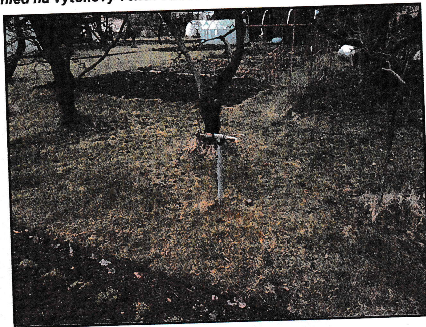
Obr. č. 7 Pohled na výtokový ventil vodovodního řadu do osady
