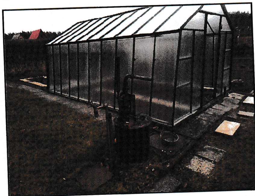
Obr. č. 8 Pohled na šachtovou studnu u chaty e.č. E84 (hloubka 3,05 m stav hladiny 2,08 m od hrany pažnice)
