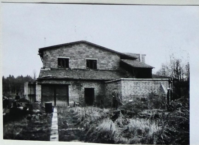
Pohled na část cihelný objektu „B“ mířena hlínou.
