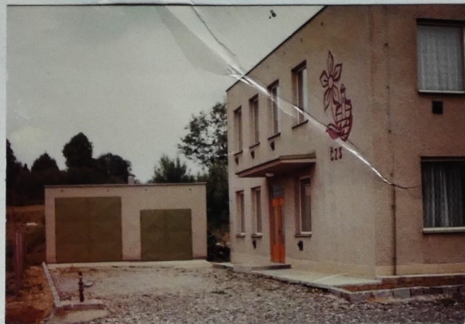
POHLED-DETAIL (před rezeťací dvora)
