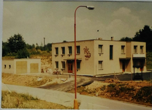
POHLED NA BUDOVU (před konečnou úpravou exteriéru)
