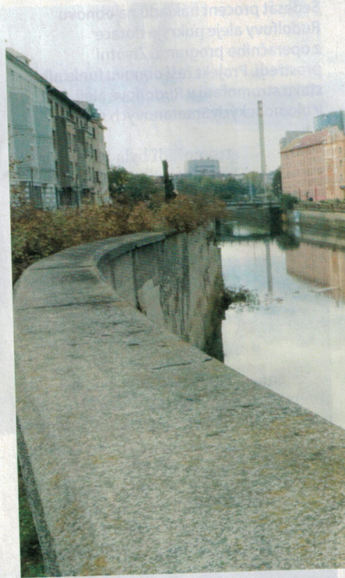
Mezi mosty podél Moravy vzniknou nové snížené bermy. Pravobřežní široká
