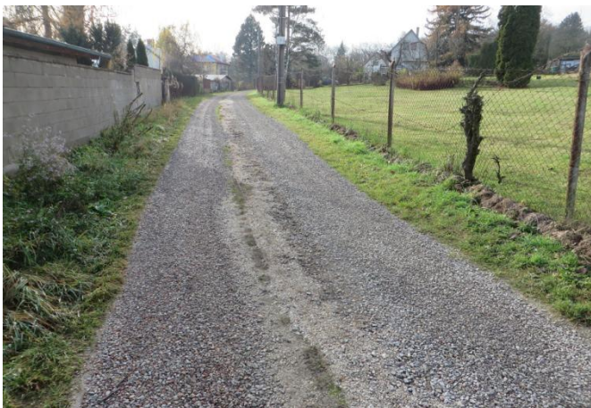
Oprava povrchu uličky „K Hájovně“
