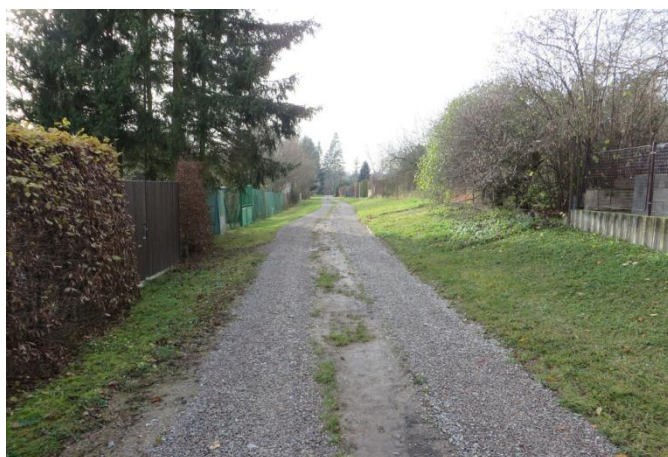
Oprava povrchu uličky „Souběžná“
