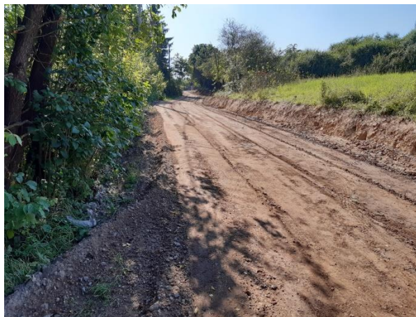
Ilustrační foto z rekonstrukce uličky Vydrova (bagrování na šíři 6m a zhutnění navezeného povrchu)
