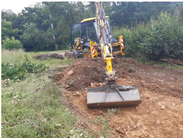
Ilustrační foto z rekonstrukce uličky Vydrova (bagrování na šíři 6m a zhutnění navezeného povrchu)
