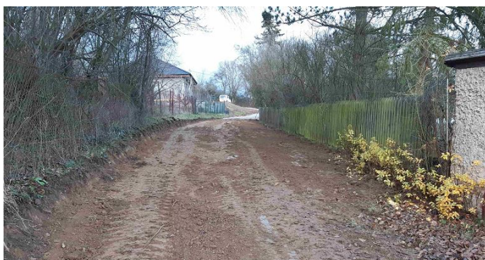
Po vybagrování šikmého terénu a odvezení přebytečné zeminy
