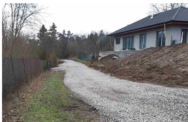
Urovnáný a uježděný povrch jízdni části – uvítáme průjezd vozidel, aby se hrubý štěrk přes zimu pevně utemoval
